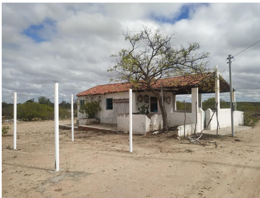
Figura 4 - Capela construída para as irmãs Maria e Augustinha
