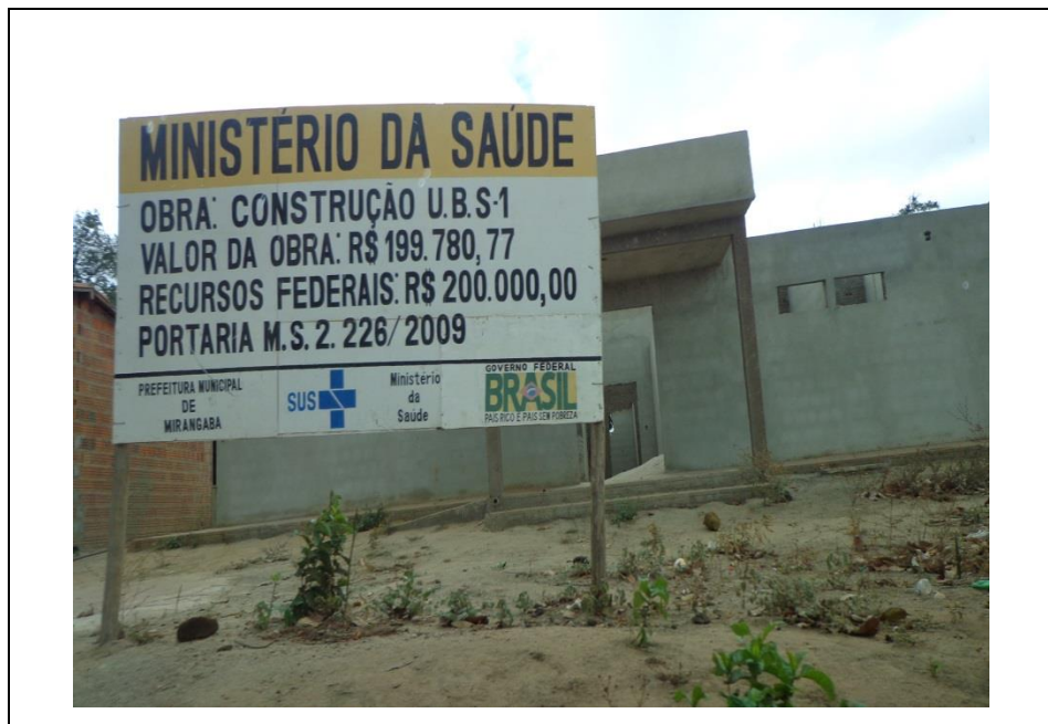
Imagem 4. Fotografia da Construção do PSF de Coqueiros. Arquivo Pessoal Jakeline Cruz, 2012.
